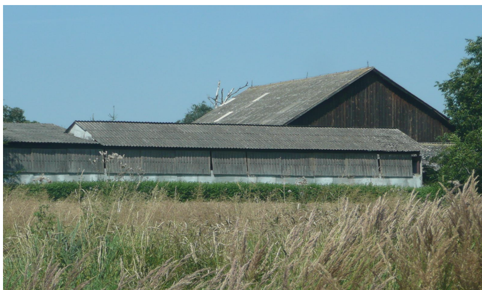
Fot. 3 Różne budynki gospodarcze pokryte płytami azbestowymi we wsi Uniejowice
