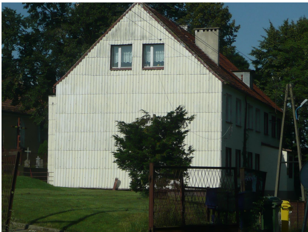
Fot. 4 Wykonana z płyt azbestowych okładzina elewacji Szkoły we wsi Brochocin.
